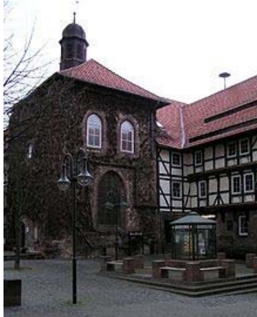
St.-Blasien-Komplex, Außenansicht der Kapelle
